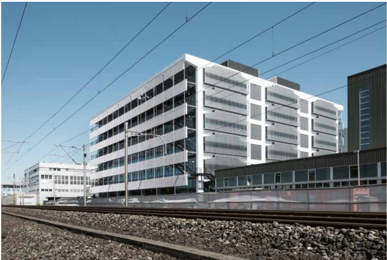
Die vorgesetzten Brises-Soleil und das Tragwerk aus Beton bestimmen die äussere Erscheinung des Baukörpers.
