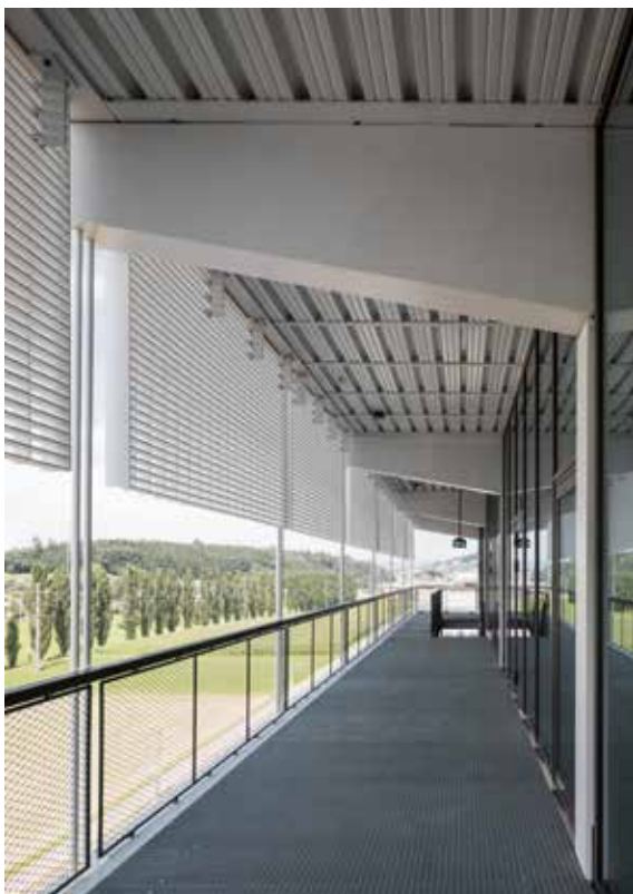
Auch die Laubgänge vereinen mehrere Funktionen zugleich. Sie sind Erschliessung, Begegnungszone und Träger der Lamellenstrukturen des Sonnenschutzes.
