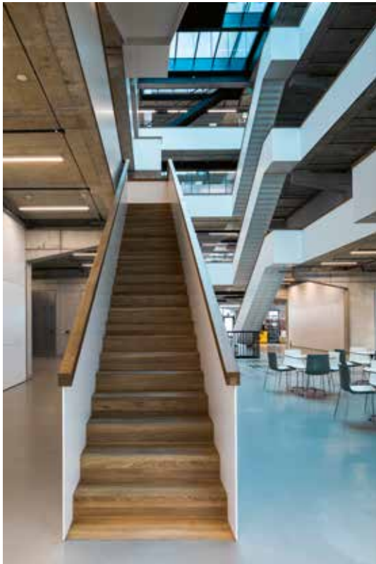
Das Atrium verfolgt zwei Lowtech-Lösungen in einer. Die Dachfenster über dem hohen Raum sorgen bei geeigneten Wetterverhältnissen zusammen mit den Fenstern in der Fassade für einen natürlichen Luftstrom und für Tageslicht im zentralen Begegnungsbereich.
