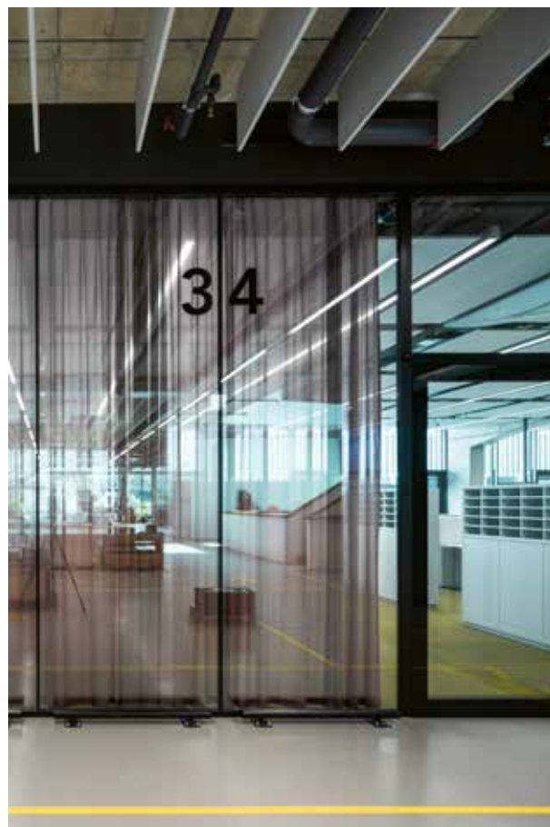
Ganz oben: Die dem einfallenden Licht angepasste Rasterung der Brise-Soleil erweist sich als eine wohltuende Gliederung der hohen Fenster. Darunter: Versetzbare Abgrenzungen definieren die Open-Space-Büros.
